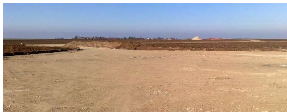
Figure 109 : Exemple d'aire de montage, grave compactée sur géotextile
